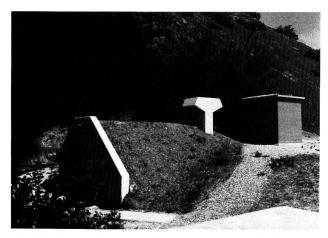
Gerade in Berggebieten kann die Trinkwasserversorgung häufig zugleich für die Stromproduktion herangezogen werden: Hier das elegant in die Landschaft eingepasste Kleinwasserkraftwerk Balavaud in der Nähe von Sitten (VS), dessen Wasser nach getaner «Arbeit» die Wasserversorgung der Gemeinden Conthey, Vétroz und Ardon speist. (Bild: Elektrowatt)
