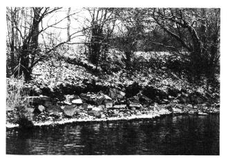
Bild 5. Uferpartie oberhalb Paradies. Die Wellen haben das feinkörnige Unterlagsmaterial aus dem Blocksatz herausgespült, so dass dieser zerfällt. Links ein Überrest des früheren Schilfgürtels.
