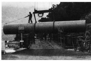
Préparation d'un tuyau sur le pont de déchargement inférieur et transport à son emplacement définitif.
