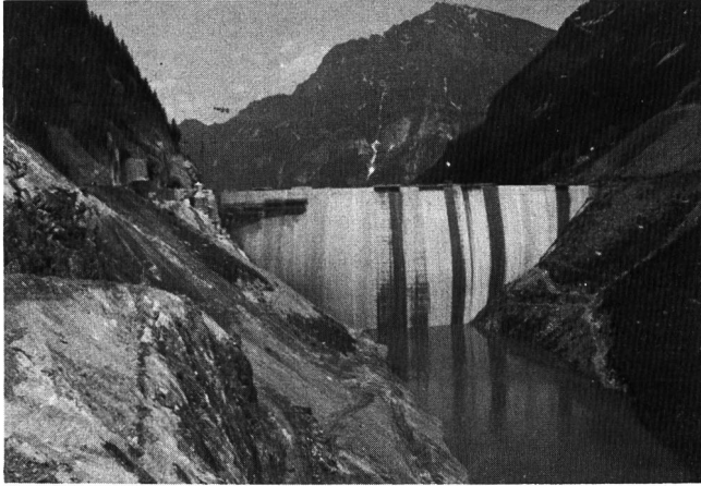
Barrage de Gigerwald, Suisse
