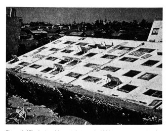
Figure 1. Niigata: tremblement de terre de 1964, renversement d'un immeuble suite à la «liquéfaction de sa fondation».
