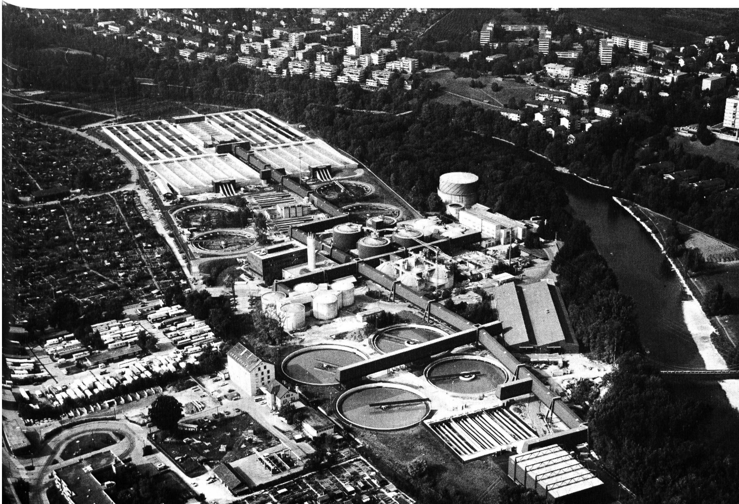
Bild 3. Flugaufnahme der erweiterten Kläranlage Werdhölzli. Im Vordergrund die mechanische Reinigungsstufe; in der Mitte die Tanks der Schlammbehandlung und das Betriebsgebäude mit dem Kamin der Energiezentrale. Im Hintergrund die biologische Reinigungsstufe mit der eingebetteten Filtrationsstufe (ganz oben im Bild). (Comet Flugbild)
