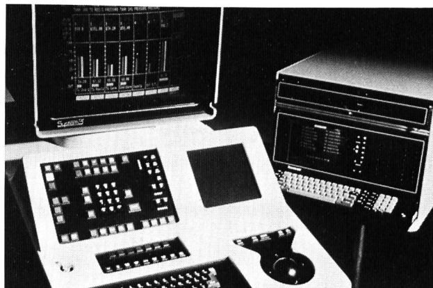
Bild 1. Bedienstation für das Prozessleitsystem RS3.
