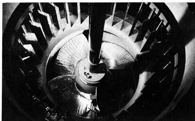
Bild 1. Die Propellerturbine mit einem Durchmesser von 3,6 m des Aarekraftwerks Schwarzhäusern wird nach über 60 Jahren Betriebszeit ersetzt.
