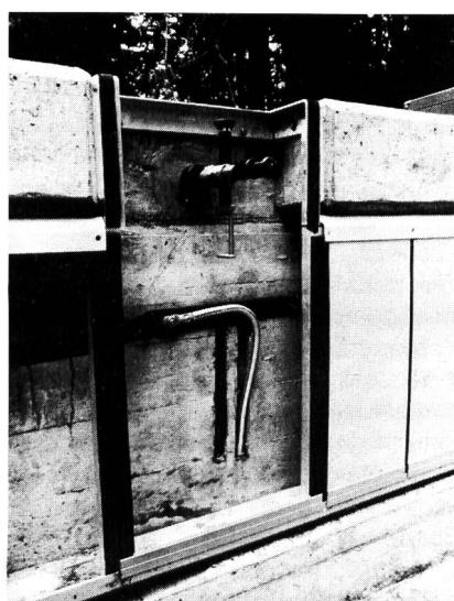
Bild 2a, links. Horizontaler Alignementdraht in der massiven Brüstung der Staumauer Rempen, Messstelle mit optischem Messinstrument.
