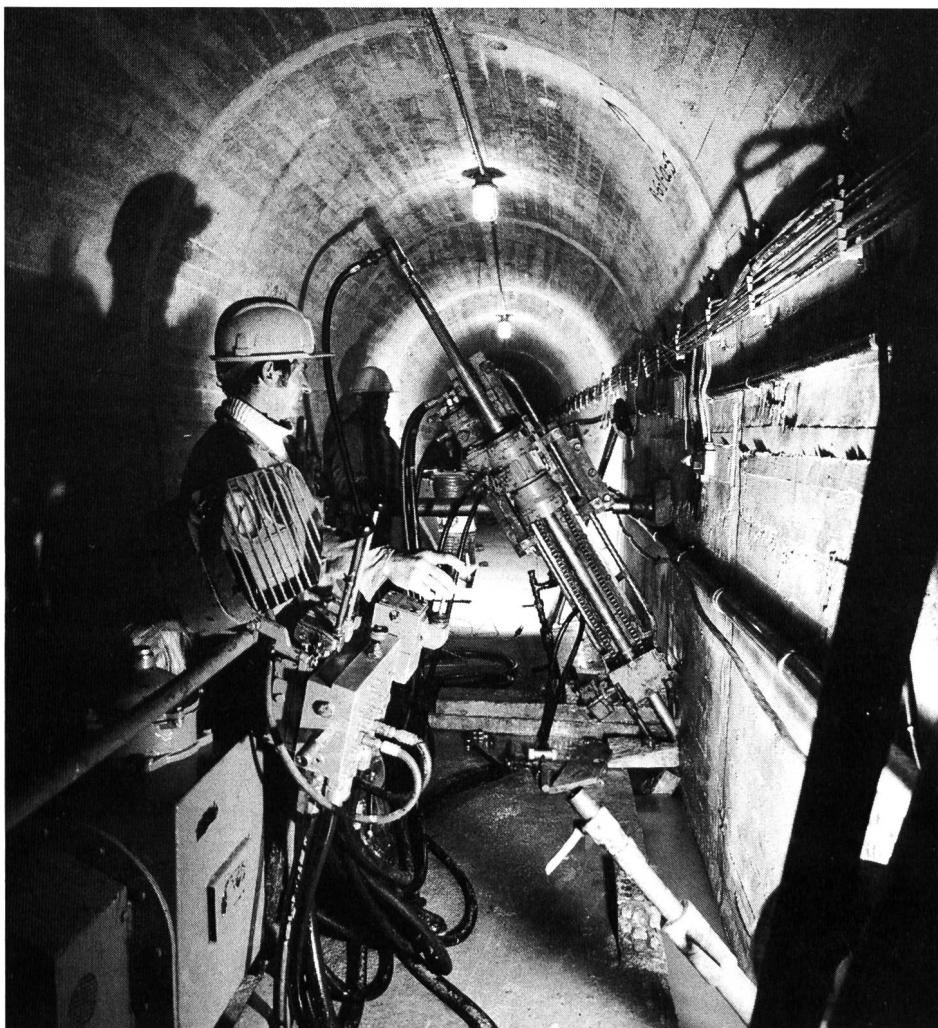
kompatte RODUR Bohr- und Injektionsanlage – Behandlung von Rissen in Massenbeton unter 90 m Wasserdruck
