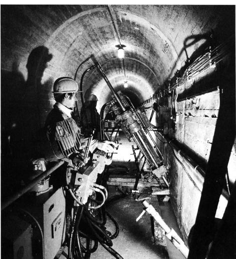
kompakte RODUR Bohr- und Injektionsanlage – Behandlung von Rissen in Massenbeton unter 90 m Wasserdruck
