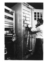
Elektronischer Turbinenregler, wie er auch im grössten Peltonturbinen-Kraftwerk der Welt eingesetzt wird.
