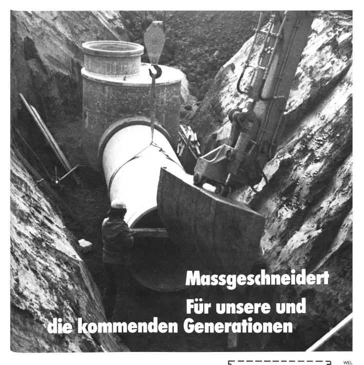
Kanalisationen und Kontrollschächte in grundwassergefährdeten Zonen unterliegen bezüglich Dichtheit strengen eidgenössischen Vorschriften. Die individuell in unserem Werk hergestellten ETERNITSchächte, in Verbindung mit ETERNIT-Kanalisationsrohren, erfüllen diese Anforderungen in jeder Hinsicht und haben sich seit Jahren bestens bewährt. Das Baustellenbild zeigt einen Kanal NW 1200 mm mit einem Kontrollschacht NW 2000 mm in der Gemeinde Kyburg SO.
