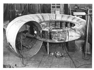
Bild 1. Turbinen-Spiralgehäuse für die Erneuerung der Wasserkraftanlage Spiez aus rostfreiem Stahl während der Herstellung in den Werkstätten von Vevev.
