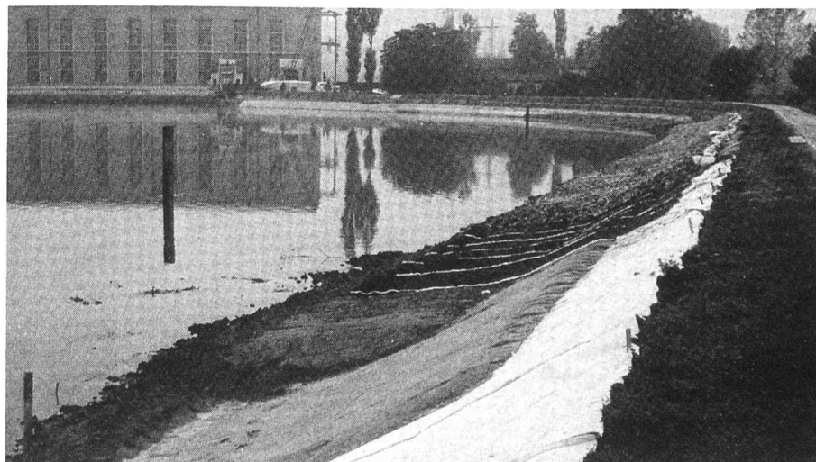
Bild 5. Schnitt (oben) und Foto (rechts) mit verschiedenen Baustadion illustrieren den Einbauvorgang der Abdichtungsauflage in der rechtsufrigen Bucht.
