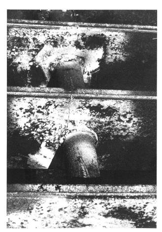
Bild 6. Bei den Distanzhaltern gebrochene Rechenstäbe. (Photo RADAG)
