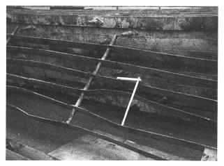
Bild 5. Deformierte Rechentafeln
