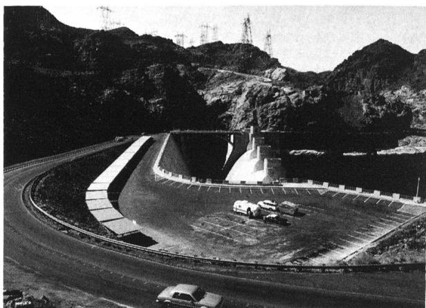
Figure 3. Les deux évacuateurs de crues, installés chacun d'un côté, ont une capacité totale de 11\,327\text{ m}^3/\text{s} . Dimensions: longueur 198 m, largeur 45 m, hauteur 52 m. Les galeries attenantes ont un diamètre de 15 m.
