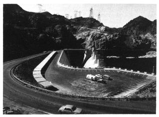
Figure 3. Les deux évacuateurs de crues, installés chacun d'un côté, ont une capacité totale de 11 327 m³/s. Dimensions: longueur 198 m, largeur 45 m, hauteur 52 m. Les galeries attenantes ont un diamètre de 15 m.
