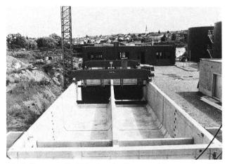
Bild 3. Die neuen Vorklärbecken der Abwasserreinigungsanlage Rietwiesen. Dahinter der Sandfang und das Maschinenhaus.
