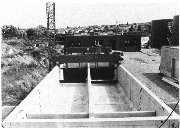
Bild 3. Die neuen Vorklärbecken der Abwasserreinigungsanlage Rietwiesen. Dahinter der Sandfang und das Maschinenhaus.
