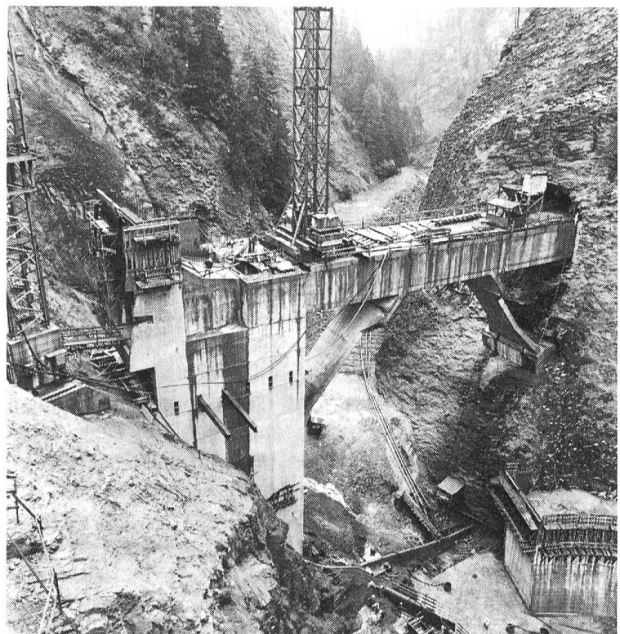
Bild 2. Die Staumauer Solis im Bau. Auf dem Boden der Albulaschlucht sind die ersten Betonblöcke der doppelt gekrümmten Bogenmauer zu erkennen.
