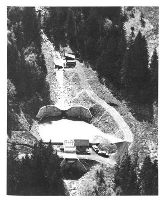
Bild 2. Messstation Erlentobel der EAFV im Alptal mit oberer Messstation, Schussrinne, Geschiebeauffangbecken und unterer Messstation mit V-Messüberfall (Einzugsgebiet 0,75 km²), Bewaldungsgrad 39%, auffangbares Geschiebevolumen 2500 m³, Dimensionierungshochwasser  $15\,\text{m}^3/\text{s}$ , überlastbar bis  $25\,\text{m}^3/\text{s}$  bei einem  $Q_{100} \simeq 12\,\text{m}^3/\text{s}$ ).
