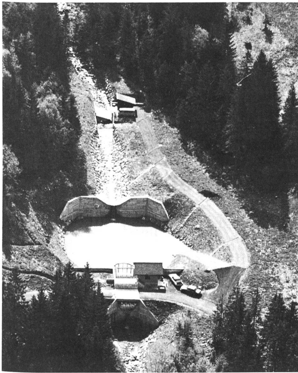
Bild 2. Messstation Erlentobel der EAFV im Alptal mit oberer Messstation, Schussrinne, Geschiebeauffangbecken und unterer Messstation mit V-Messüberfall (Einzugsgebiet 0,75 km 2 , Bewaldungsgrad 39%, auffangbares Geschiebevolumen 2500 m 3 , Dimensionierungshochwasser 15 m 3 /s, überlastbar bis 25 m 3 /s bei einem Q 100 ≈ 12 m 3 /s). (Foto Militärlugdienst)
