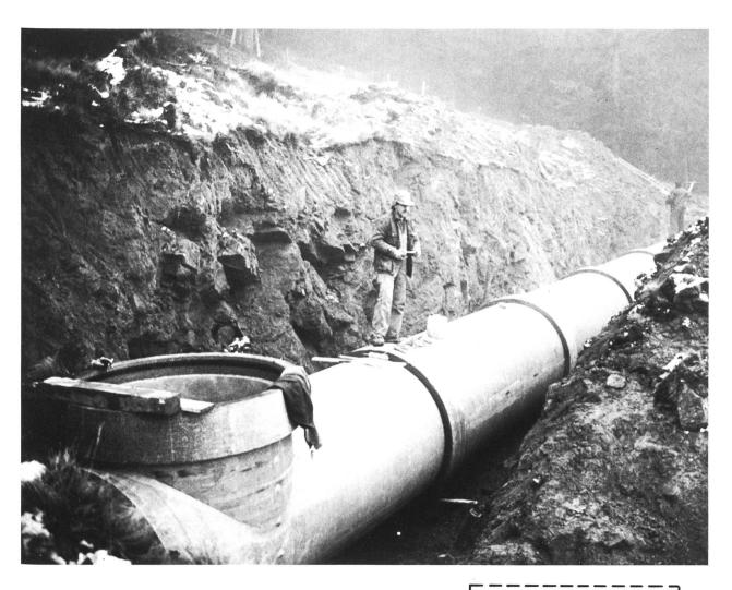
Für das Hotel Langis auf dem Glaubenberg ob Sarnen musste im Spätherbst 1984 kurzfristig ein Trinkwasserreservoir von 30 m³ Inhalt gebaut werden. Im Eternit-Werk wurde der Behälter mit sämtlichen Armaturen und in montagegerechten Elementen und in montage-gerechten Elementen vorfabriziert. Wegen des recht unwegsamen Reservoir-standortes erfolgte das Versetzen mittels Helikopter. Die gewählte Variante erwies sich im Vergleich zu Ortsbeton als be-
