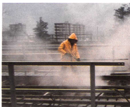
Hochdruck-Wassersandstrahlen
