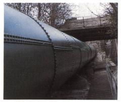
Aussenkorrosionsschutz einer Druckleitung
