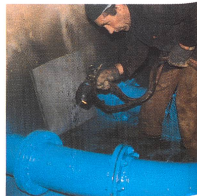
Beschichtung von Leitungen mit Kondenswasser
