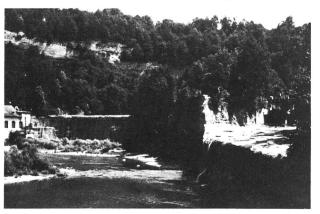
$Bild\ 3.\ Luftseitige\ Ansicht\ der\ Gewichtsstaumauer\ P\'erolles\ an\ der\ Sarine\ ob\ Fribourg/FR\ mit\ rechts\ dem\ Hochwasserentlastungskanal.$
