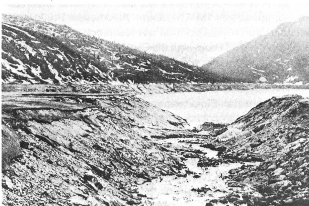
Bild 5. Erosionsrinne im Bachkegel des Tomsee-Abflusses im Ritomsee nach 9 Monaten Absenkung am 30. Juni 1917 (Foto C. Ghezzi, aus Collet et al., 1918).
