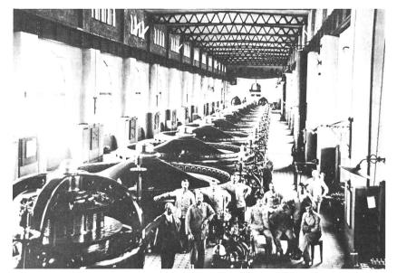
Bild 8. Aarekraftwerk Beznau, Inbetriebnahme 1902. Der Maschinensaal zeigt die Generatoren der 11 vertikalachsigen Turbinen. Diese gehören zu den Spitzenprodukten ihrer Zeit.
