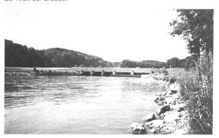
Bild 5. Aarekraftwerk Bannwil, Inbetriebnahme 1970. Ansicht vom Unterwasser. Die Architektur bindet Maschinenhaus (rechts) und Wehr (links) zu einem Zweckbau zusammen. Dieser duckt sich gleichsam zwischen die Ufer
