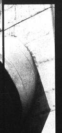
Für Hochdruck-Kraftwerk: Druckleitung.
