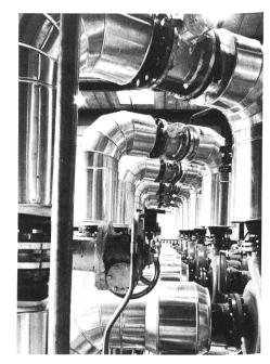
Figure 3. Station centrale de pompage. Par l'intermédiaire des pompes que l'on reconnaît au premier plan, la température du réseau Refuna est réglée à une valeur comprise entre 120° C, en hiver, et 75° C, en été.
