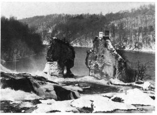
Nach Abschluss der Sanierungsarbeiten am Rheinfallfelsen in Schaffhausen präsentieren sich die beiden Zähne wieder in alter Form, aber mit neuem Kleid. Die der Felsoberfläche angepasste Spritzbetonschicht wird mit der ansetzenden Patina nach kurzer Zeit kaum mehr als künstliche Massnahme wahrzunehmen sein. (Foto: Ch. Messerli, Schaffhausen)
