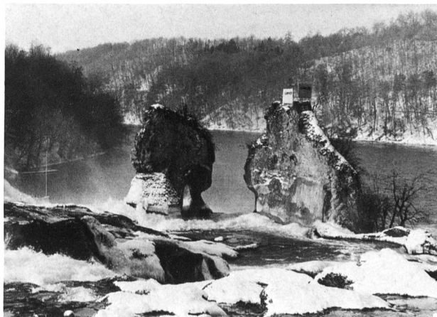
Nach Abschluss der Sanierungsarbeiten am Rheinfallfelsens in Schaffhausen präsentieren sich die beiden Zähne wieder in alter Form, aber mit neuem Kleid. Die der Felsoberfläche angepasste Spritzbetonschicht wird mit der ansetzenden Patina nach kurzer Zeit kaum mehr als künstliche Massnahme wahrzunehmen sein. (Foto: Ch. Messerli, Schaffhausen)
