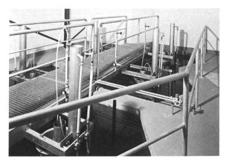
Bild 6. DynaSand-Filter der ARA Maur/ZH. 6 Filter à je 3 m². Anlageleistung 288 m³/h.
