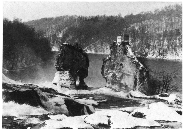
Nach Abschluss der Sanierungsarbeiten am Rheinfallfelsens in Schaffhausen präsentieren sich die beiden Zähne wieder in alter Form, aber mit neuem Kleid. Die der Felsoberfläche angepasste Spritzbetonschicht wird mit der ansetzenden Patina nach kurzer Zeit kaum mehr als künstliche Massnahme wahrzunehmen sein. (Foto: Ch. Messerli, Schaffhausen)
