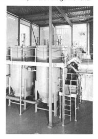
Bild 8. DynaSand-Filter ARA Mönchaltorf/ZH. 2 Filter à je 9 m². Anlageleistung 252
