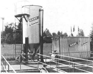
Bild 5. DynaSand-Filter als Einzelelement.
