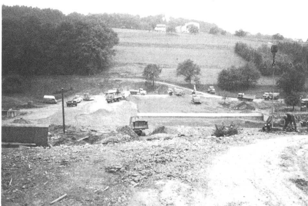
Bild 5. Dammschüttung (linke Bildhälfte) und Schüttung des Drainage-teppichs (rechte Bildhälfte).
