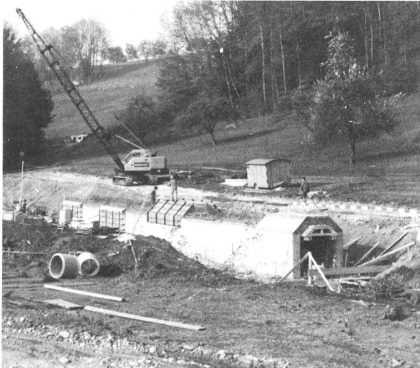
Bild 4. Bau des Grundablass-Durchlasses von der Unterwasserseite her gesehen.
