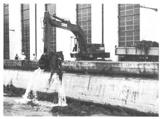
Bild 11. Einsatz eines hydraulischen Baggers bei Wasserpflanzenanfall am Rechen des Rheinkraftwerkes Albbruck-Dogern (Photo *L. Kranich*).
