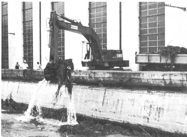
Bild 11. Einsatz eines hydraulischen Baggers bei Wasserpflanzenanfall am Rechen des Rheinkraftwerkes Albrück-Dogern (Photo L. Kranich).
