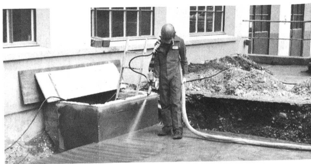
Applikation einer «Vateg»-Unterterrain-Flachdachabdichtung.
