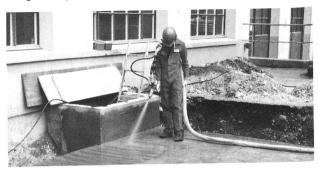
Applikation einer «Vatec»-Unterterrain-Flachdachabdichtung.
