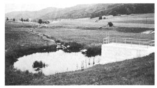
Bild 4. Das Rückhaltebecken mit Entlastungsbauwerk, Blick Richtung Oberhofen.
