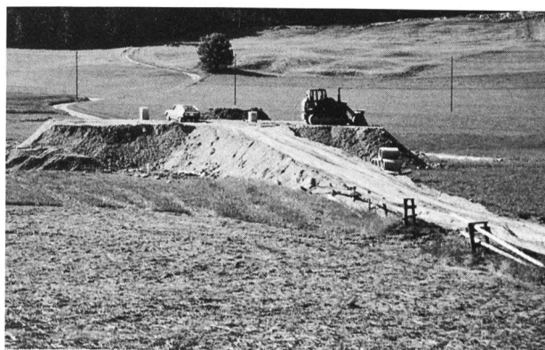
Bild 10. Vorbelastung des Dammuntergrundes, Juni 1981.
