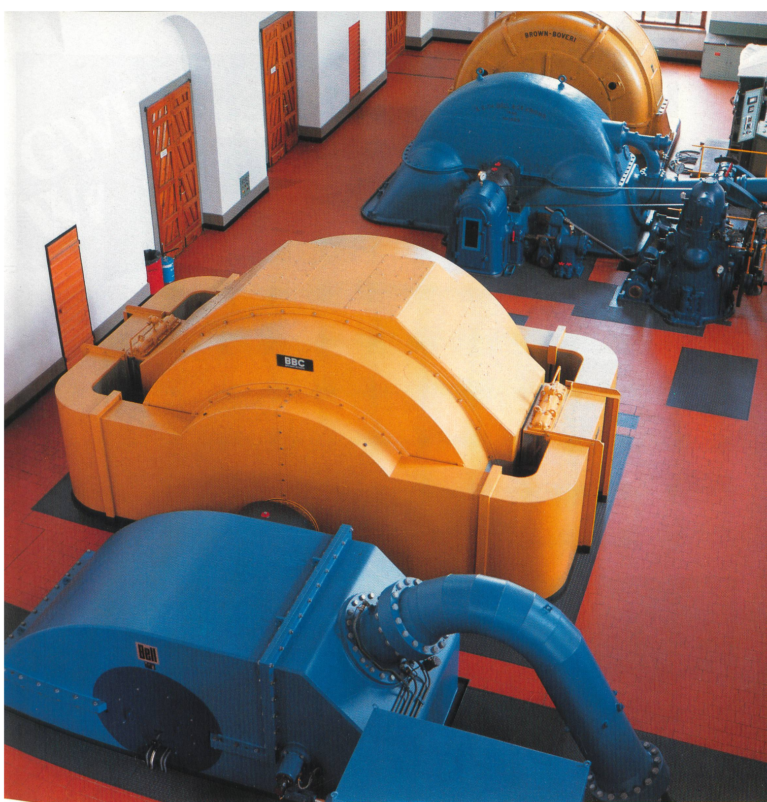
10-MVA-Einphasen-Wasserkraftgenerator für 16 \frac{2}{3} Hz der Bündner Kraftwerke in Klosters. Die neue Maschine wurde anstelle einer alten 10-MVA-Dreiphasenmaschine für 50 Hz eingebaut. Trotz knappster Platzverhältnisse konnte der Einbau des neuen Generators mit dreifacher Typenleistung realisiert werden.
