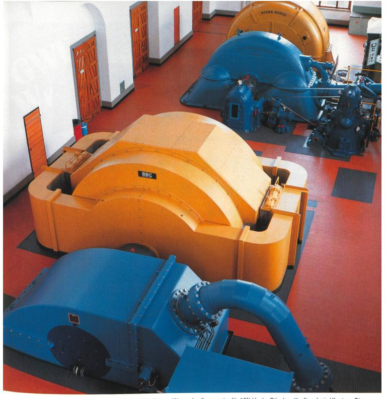
10-MVA-Einphasen-Wasserkraftgenerator für 16% Hz der Bündner Kraftwerke in Klosters. Die neue Maschine wurde anstelle einer alten 10-MVA-Dreiphasenmaschine für 50 Hz eingebaut. Trotz knappster Platzverhältnisse konnte der Einbau des neuen Generators mit dreifacher Typenleistung realisiert werden.
