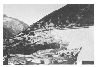
Bild 5. Die 35 m hohe Gewichtsmauer Gelmer wurde 1927/29 erbaut. Sie staut den Gelmersee mit einem Inhalt von 13,5 Mio m³ auf Kote 1850. Der Grundablass wurde 1984 neu gebaut. Vergleiche auch das Farbtitelblatt dieser Ausgabe.
