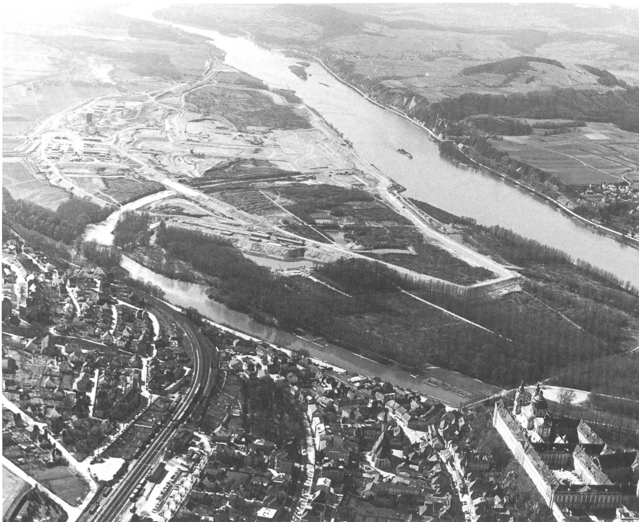
Bild 2. Hochwasserfrei angelegte Baugrube für das Donaukraftwerk Melk im April 1979. Vorne rechts das Barockstift Melk.
