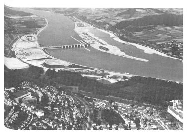
Bild 5. Donaukraftwerk nach Vollinbetriebnahme Mitte August 1982 und Beginn der Rekultivierungsarbeiten am Altarm des Stroms (rechts vom Hauptbauwerk); der Auwald unterhalb des Stiftsfelsens blieb von den Bauarbeiten unberührt.
