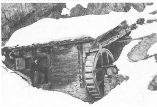
Bild 1: Dieses oberschlächtige Wasserrad aus Törbel im Vispertal VS trieb eine Hammerwalke für Textilgewebe an. Das Technorama der Schweiz rettete dieses Rad mit Walke 1959 vor der Zerstörung. Konserviert wartet es auf einen Einsatz in der Ausstellung. Die Erhaltung von Wasserrädern löst hohe Kosten aus. Ein Inventar vorhandener Wasserräder, in Vorbereitung durch das Technorama der Schweiz, erleichtert den sinnvollen Einsatz der Mittel von Denkmalpflege und Museen.
