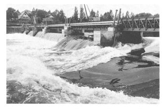
Bild 1. Ansicht des umgebauten Wehres von der Unterwasserseite her. Im Vordergrund die drei hydraulisch betätigten Wehrklappen in unterschiedlicher Öffnungsstellung. Die drei Wehröffnungen im Hintergrund besitzen nach wie vor die alte Schleusenausrüstung.
