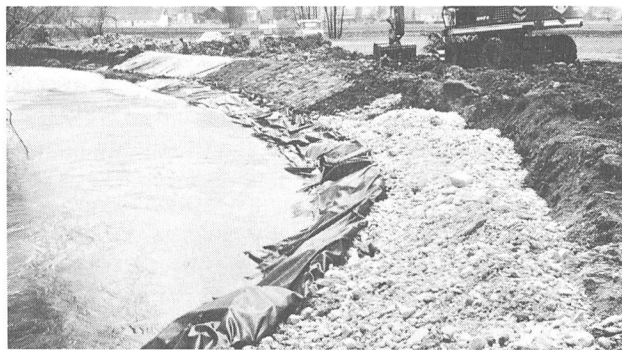
Figure 8. Détail de remplissage du géotextile. 27.4.82.
