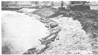
Figure 8. Détail de remplissage du géotextile. 27.4.82
