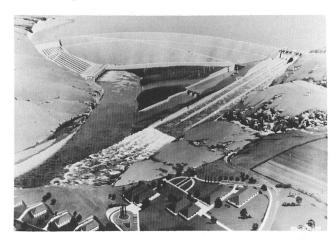
Bild 2. Projektansicht des Wasserkraftwerks «Atatürk». Die installierte Leistung wird 8  $\times$  300 MW betragen, die jährliche Stromproduktion rund 8 Mrd. kWh. BBC Brown Boveri und Sulzer-Escher Wyss werden die gesamte elektrische und hydraulische Ausrüstung liefern.
