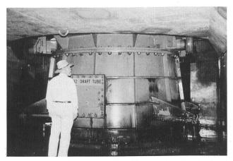
Bild 10. Besonders wartungsfreundlich ist diese Anordnung einer Francisturbine mit ausfahrbarem Saugrohr. Binnen weniger Stunden ist das Laufrad zugänglich und kann nach unten ausgebaut werden. Für sehr grosse Pumpturbinen wird jedoch aus Festigkeits- und Lärmschutzgründen das Saugrohr vollständig einbetoniert.
