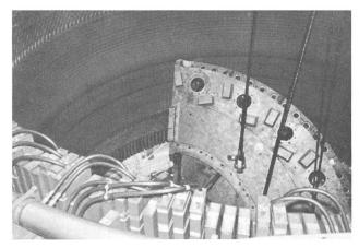
Bilder 5 und 6. Da eine Zwischenwelle fehlt, muss nicht nur die Pumpturbine selbst, sondern auch der Motorgenerator demontiert werden. Die Statorbohrung ist nicht gross genug, um den Ausbau des Turbinendekkels im ganzen zu ermöglichen – eine weitere Komplikation. Hier (Bild 5)
