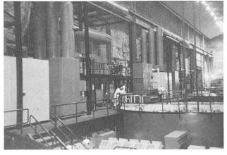
Bild 1. Blick in die Kaverne eines grossen Pumpspeicherwerkes (Raccoon Mountain, Tennessee, 4  $\times$  380 MW). Man erkennt die Generator-Schalter und -Ableitungen. Die Kavernenwände sind unverkleidet.
