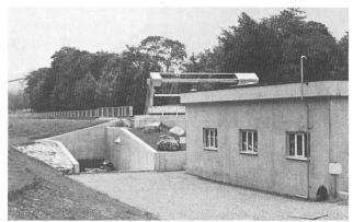
Bild 5. Zentralengebäude mit Rechenreinigungsmaschine und Schwemmgutgrube.
