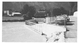
Bild 2. Die neue Wasserfassung mit Schwimmbalken
