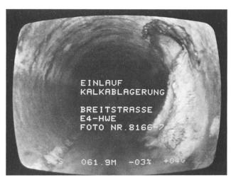
Bild 4. Monitorbild beschriftet mit Messdatenzeile unten: Distanz, Gefälle, Querneigung des Kamerawagens.
