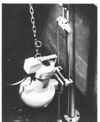
Bild 7. Einhängevorrichtung Tauchmotorpumpen (KSB, Zürich).
