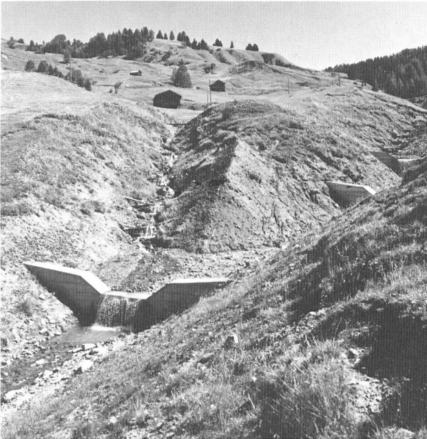
Bild 1. Begrünungen leisten auch oberhalb der Waldgrenze einen wichtigen Beitrag zur Erosionsbekämpfung, wenn die Gerinnesohlen fixiert und die Abrisskanten abgeflacht sind.
