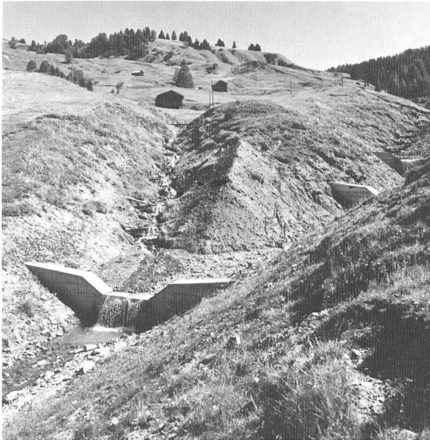
Bild 1. Begrünungen leisten auch oberhalb der Waldgrenze einen wichtigen Beitrag zur Erosionsbekämpfung, wenn die Gerinnesohlen fixiert und die Abrisskanten abgeflacht sind.
