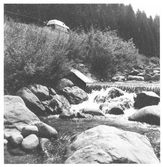
Bild 3. Die Sperren fixieren das Gefälle der Sohle auf 3 %. Den Uferschutz übernehmen Weidenspreitlagen, die ihrerseits mit Steinblöcken gegen Unterspülung gesichert sind. Diese Verbauung hat bereits nach wenigen Monaten eine Schleppspannung von 12 kg/m² schadlos überstanden.
