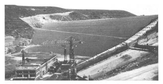
Bild 2. Der Damm der Anlage Alicura flussaufwärts aufgenommen (es fehlen noch rund 30 m bis zur endgültigen Schütthöhe). Im Vordergrund die Schussrinne der Hochwasserentlastung, dahinter die Druckleitungen und die Zentrale.
