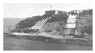
Bild 4. Im Hintergrund links der nahezu vollendete Damm. In Bildmitte Fassungsbauwerk, Druckleitungen und Zentrale. Rechts davon Hochwasserentlastung mit Einlaufbauwerk und Schussrinne.
