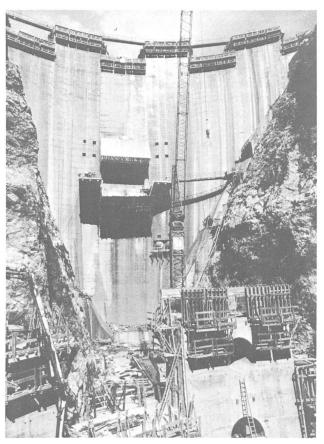
Bild 5. Doppeltgekrümmte Bogenstaumauer bei Oymapinar, Ansicht.
