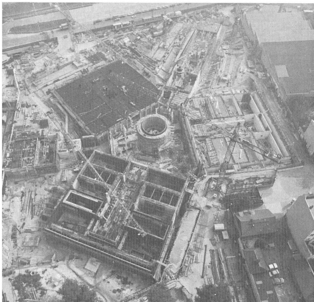
Bild 3. Entphosphatungsanlage im Bau. Blick auf das Mittelbauwerk mit Verteilerturm und die drei Filtergebäude.
