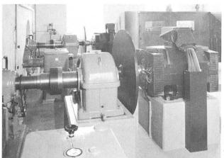
Bild 13. Wasserkraftwerk Landquart I der Papierfabriken Landquart. Zwei horizontale Asynchrongeneratoren Typ QO 355 M 6, Bauform IM B3, Antrieb durch Francisturbine über Getriebe. Nenndaten (für eine Maschine):  $U_{\rm h} = 400\,{\rm V}, P_{\rm h} = 250\,{\rm kW}, \cos\phi_{\rm h} = 0,83\,n_{\rm h} = 1015\,{\rm min}^{-1},$  Überdrehzahl = 2250 min $^{-1}$ . Inbetriebnahme 1977.
