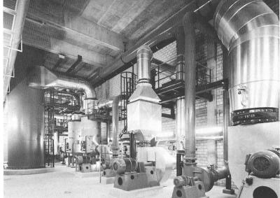
Bild 9, links. Ofenhalle, im Vordergrund Etagenwirbler mit Abgasrückführung, dahinter Abwärmeverwertung mit Luftvorwärmung und Thermoölkessel. Bild 10, rechts. Das Bild zeigt die Gebläsestation mit Abgasaufwärmung und Abgaskaminunterteil.
