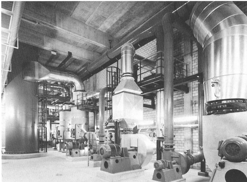
Bild 9, links. Ofenhalle, im Vordergrund Etagenwirbler mit Abgasrückführung, dahinter Abwärmeverwertung mit Luftvorwärmung und Thermoölkessel.
