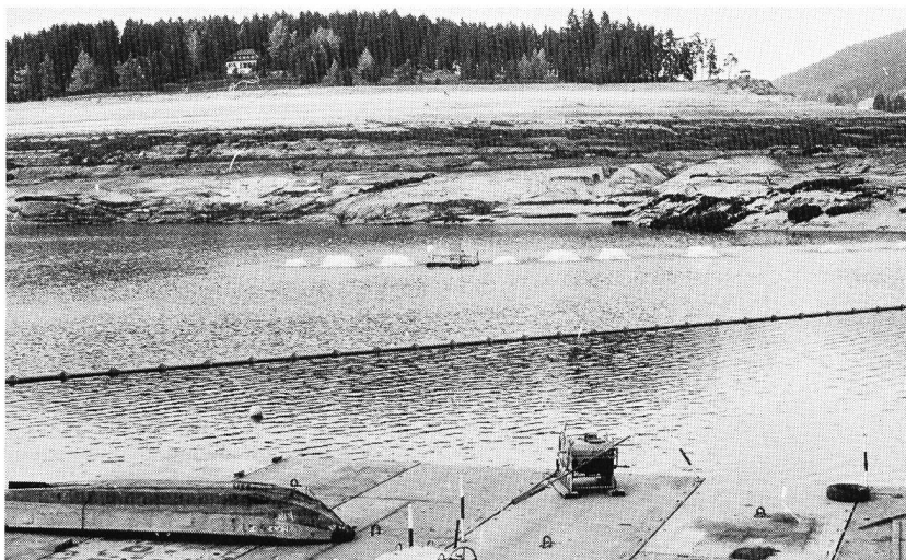
Bild 2, links. Blick von der Baustelle für die Erneuerung des Einlaufes zum Druckstollen Richtung Nord in den abgesenkten Schluchsee. In Bildmitte sind die Fontänen der Belüftungsanlage zu erkennen, die für genügend Sauerstoff zum Überleben der Fische im abgesenkten See sorgen soll. Die schwarzen Flecken im Mittelgrund rechts sind abgesunkene Torfinseln. (Foto Dr. A. Lambert vom 28. Oktober 1983).
