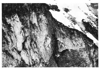
Bild 1. Potentielle Ablösungsstelle eines Felssturzes über dem Bannalp-Damm, Luftaufnahme.
