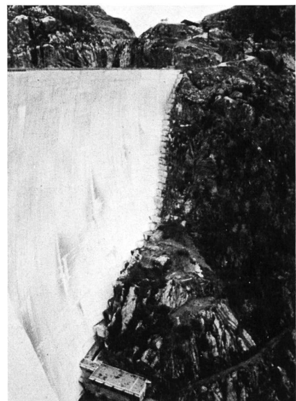
Bild 7. Linkes Widerlager der Staumauer Emosson. Dieses Bild wurde vorsorglich als Grundlage für die Kontrolle und Überwachung der Abwitterung des Sperrenwiderlagers aufgenommen.
