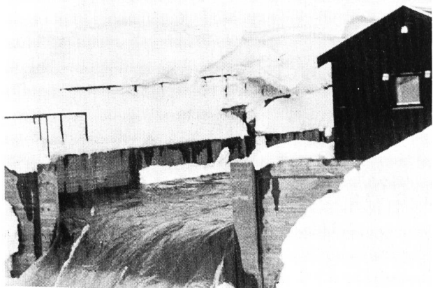
Der Stausee Skjomen in Norwegen, dessen Wasserstand mit einer Rittmeyer-Präzisions-Druckmesswaage gemessen und ferngemeldet wird.
