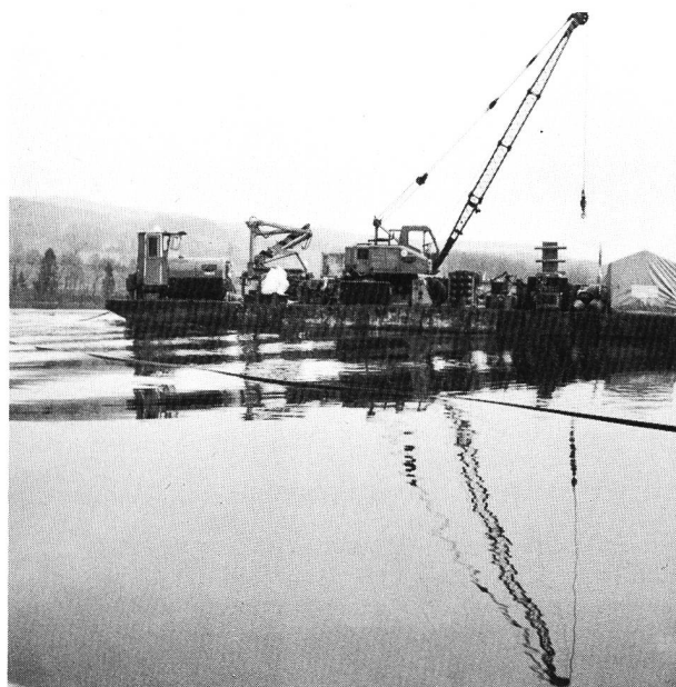
Verlegen der Beatmungsleitungen im Baldeggersee Arbeitsponton
