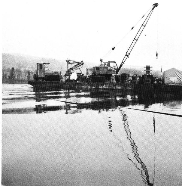
Verlegen der Beatmungsleitungen im Baldeggersee Arbeitsponton
